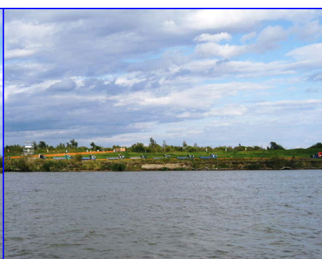
石狩市に近い川で護岸工事中
