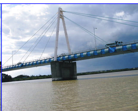
石狩河口橋を横に見て志美運河へ入る
